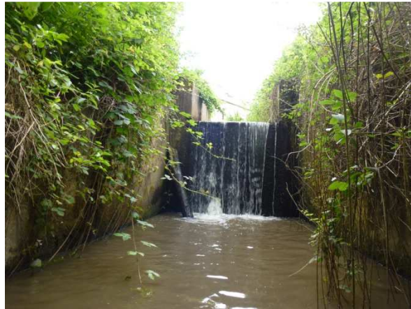
Figure 2.13 : Chute sur le bief du moulin de Béchereau
