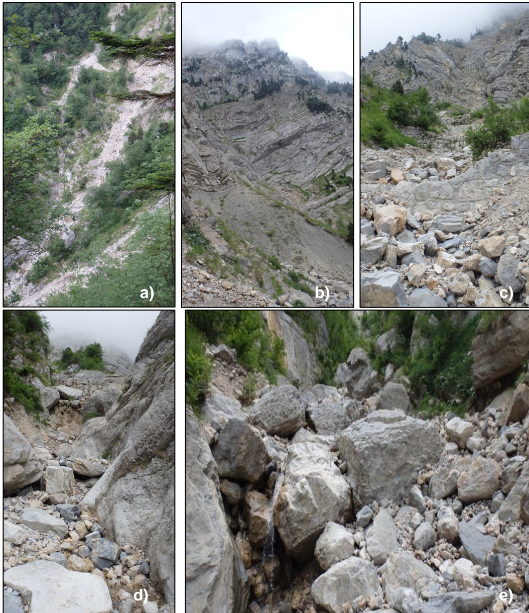
Figure 10 : a) branches du haut bassin versant de la Roize b) falaises du haut bassin versant c) ouvrages installés en contrebas des falaises d) verrou rocheux principal e) à l'aval du verrou rocheux
