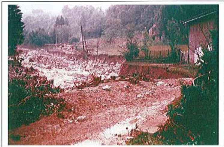
Erosion de berge en rive gauche du torrent de la Roize, à l'amont du pont de Gigot suite à la crue de juillet 1971. la route et la culée du pont en rive gauche ont été totalement emportés.
