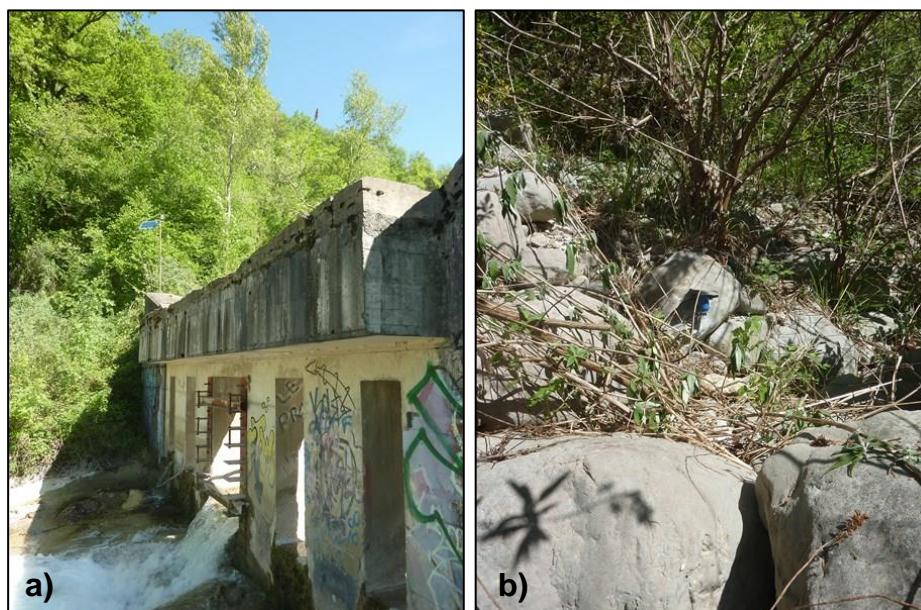
Figure 69 : a) panneau solaire et caméra installés sur le barrage de la PDD b) géophone installé à l'amont
