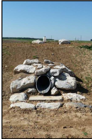
Figure 38 : Enrochement à l'arrivée dans la ZTHA (site pilote de Rampillon)
