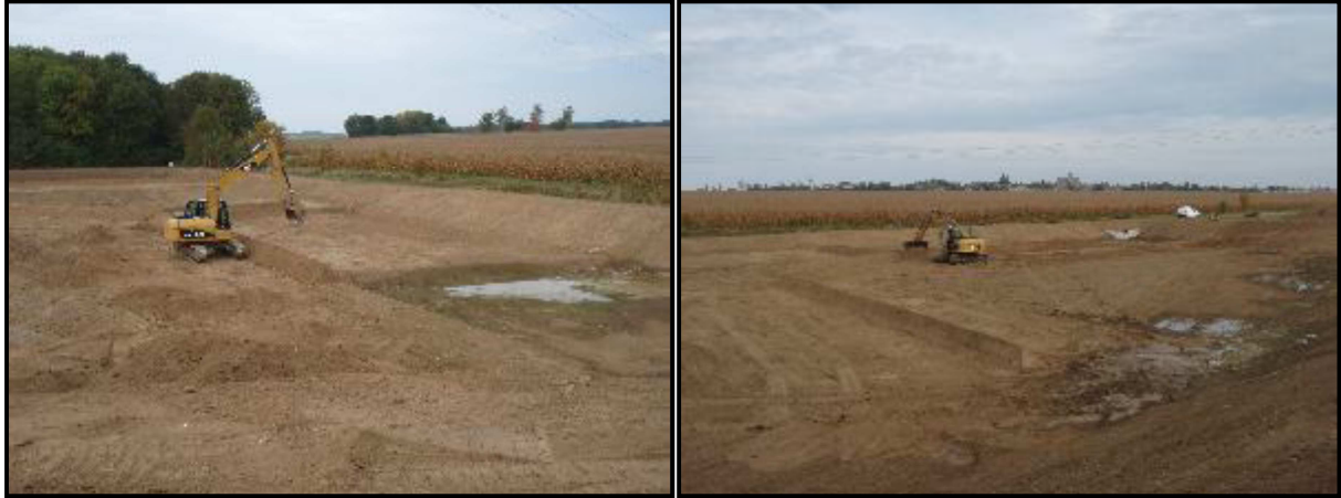
Figure 46 : Mise en place des diguettes sur la ZTHA de Rampillon
