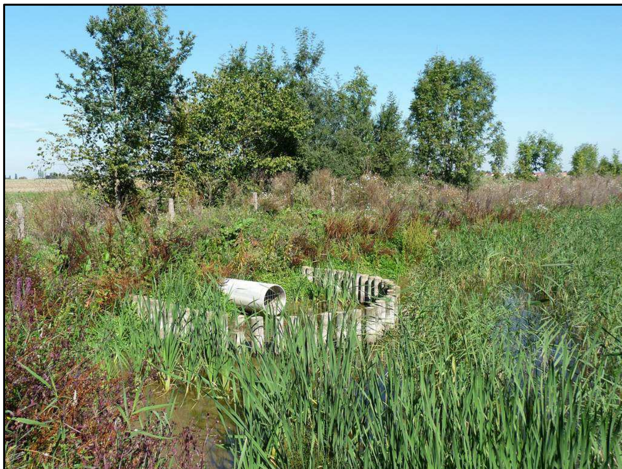
Figure 13 : Exutoire de la ZTHA végétalisée de Rampillon
