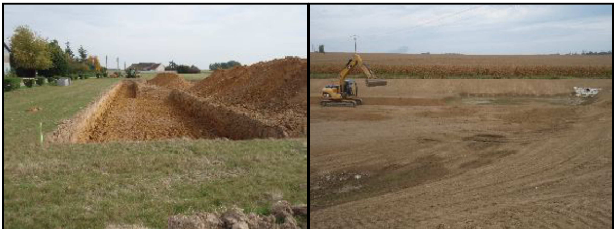
Figure 44 : Terrassement d'un bassin de Rampillon
