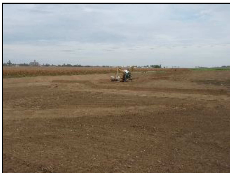
Figure 45 : Opération de compactage sur la ZTHA de Rampillon
