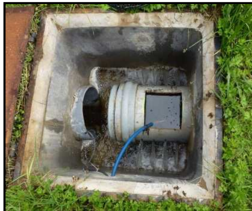
Figure 41 : Ouvrage de vidange de la ZTHA de Rampillon
