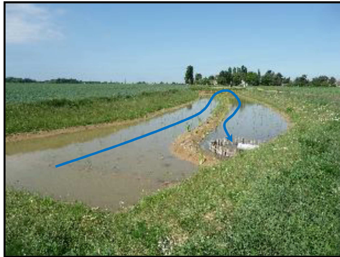
Figure 11 : ZTHA en cours de végétalisation avec une diguette centrale
