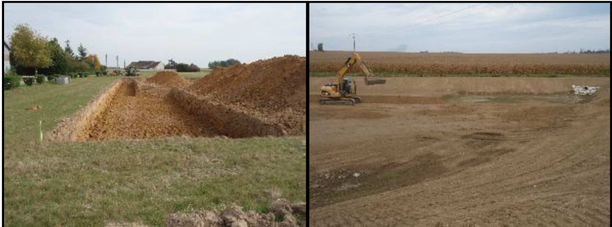
Figure 44 : Terrassement d'un bassin de Rampillon
