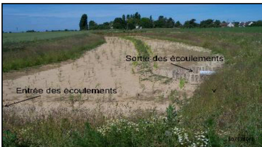
Figure 28 : ZTHA des Vaux avec entrée et sortie proches mais séparées par une diguette centrale (bassin versant de Rampillon)
