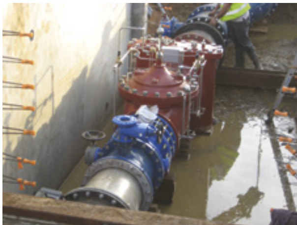
Figure 21 : Vanne de modulation de pression DN 500 mm (Suez)
