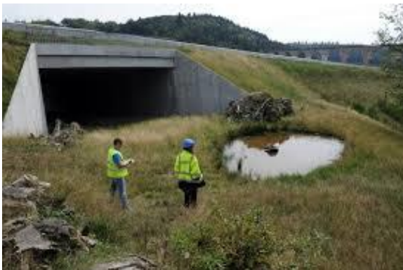
Photo 2. A89 Balbigny – La Tour de Salvagny: un passage pour la faune sauvage
