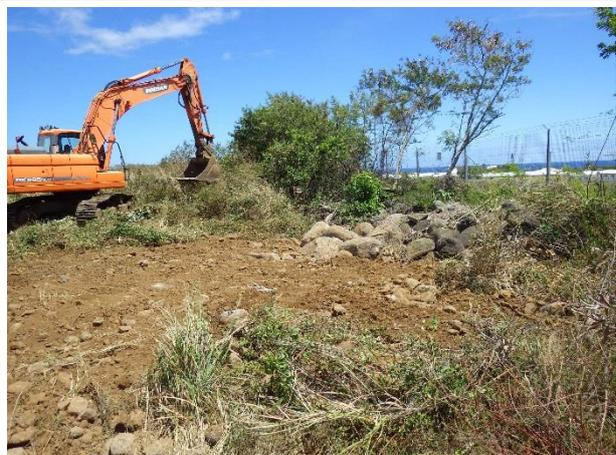
Photo 26 : Reconstitution du talus de digue – vue des matériaux de remblais postérieurs à la construction
