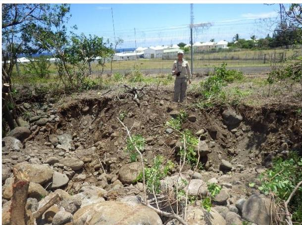
Photo 25 : Fosse d'extraction de systèmes racinaires – vue des matériaux de la digue extraits de la rivière
