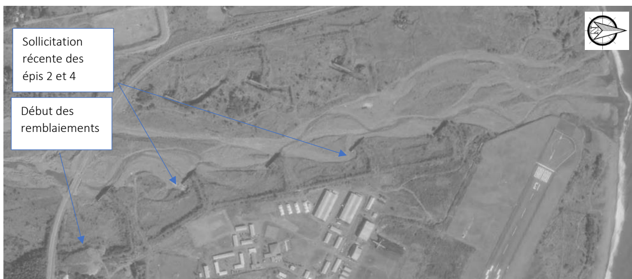
Vue aérienne du 11/05/1978 : Vue des ouvrages 5 ans après la fin des travaux. Les gabions ont joué leur rôle protecteur côté amont de épis.
