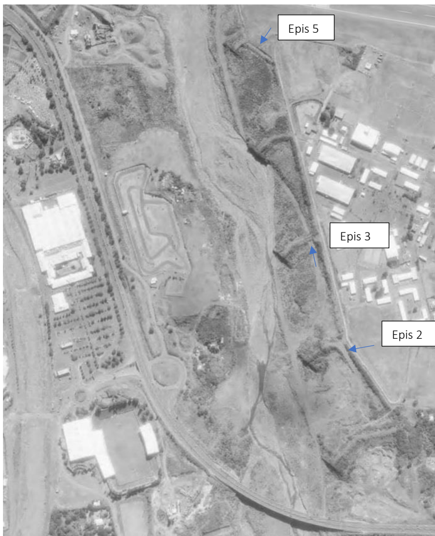
Vue aérienne du 14/07/1997 : Vue des ouvrages 24 ans après la fin des travaux.
