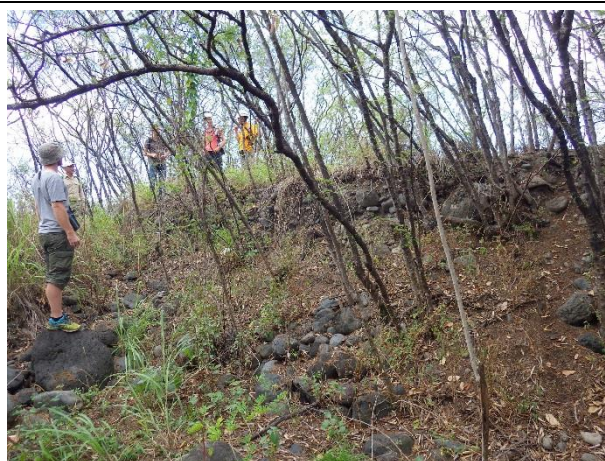
Photo 38 : Affaissement de l'épi 3 lié à la réalisation d'une piste de franchissement dans les années 1990
