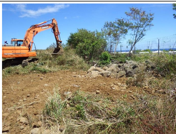
Photo 26 : Reconstitution du talus de digue – vue des matériaux de remblais postérieurs à la construction
