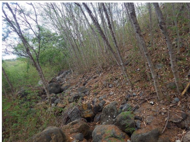
Photo 57 : Secteur ne présentant aucune difficulté pour les inspections visuelles (talus aval épi 1)
