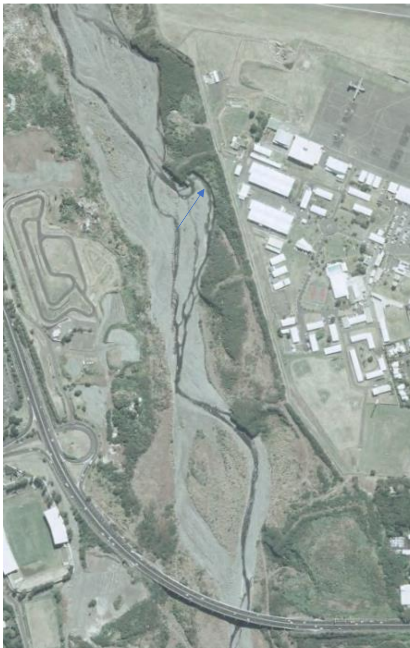
Vue aérienne du 03/07/2003 : ouvrages 30 ans après la fin des travaux.
