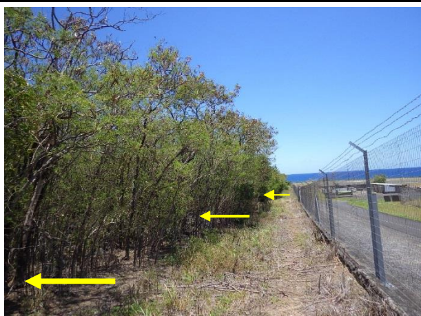
Photo 59 : Implantation (exemple théorique) des layons de 2-3 m de long et 1,5m de large au maximum à réaliser pour la visualisation du talus de digue
