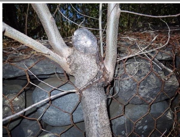
Photo 46 : Cas d'un arbre ayant poussé au travers du grillage et risquant le faire céder à terme
