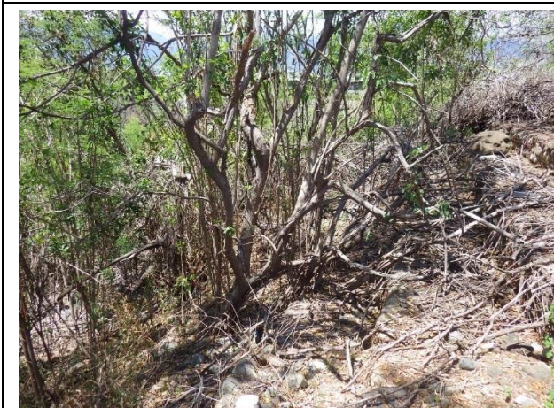
Photo 45 : Arbres enracinés dans les gabions et bois mort accumulé gênant leur visualisation
