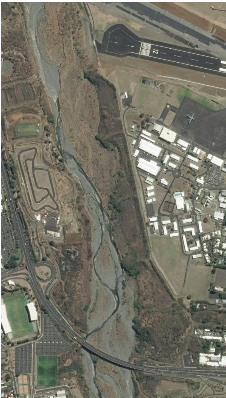
Vue aérienne du 12/12/2014 : ouvrages 41 ans après la fin des travaux
