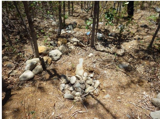
Photo 40 : Dégradations d'origines anthropiques sur les épis (trous creusés et - parfois- rebouchés par des blocs, nombreux déchets)
