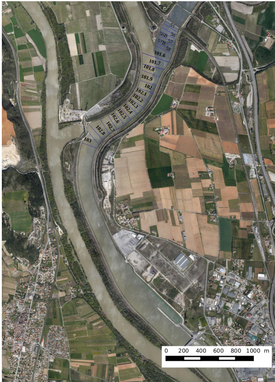
Figure 21: Image aérienne de la confluence Rhône-Isère pendant la crue/chasse de mai 2015 (source : GoogleMap).
