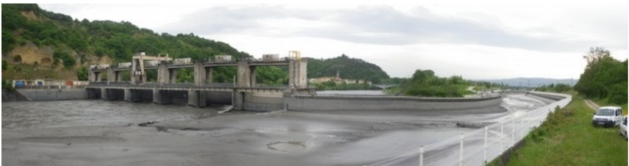
Figure 15: Photographie du barrage de Beaumont-Monteux pendant la chasse (04/05/2015)
