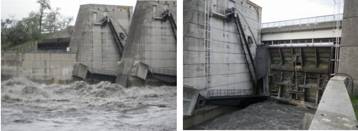
Figure 17: Photographies du barrage Isère pendant la chasse (04/05/2015)
