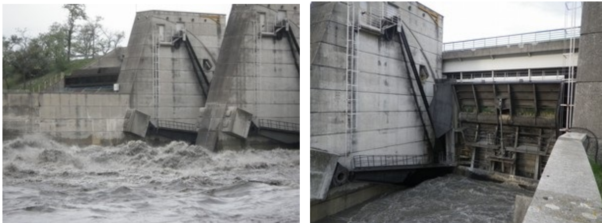
Figure 17: Photographies du barrage Isère pendant la chasse (04/05/2015)
