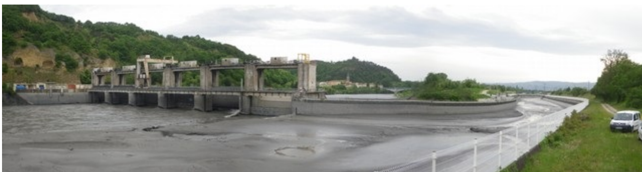
Figure 15: Photographie du barrage de Beaumont-Monteux pendant la chasse (04/05/2015)
