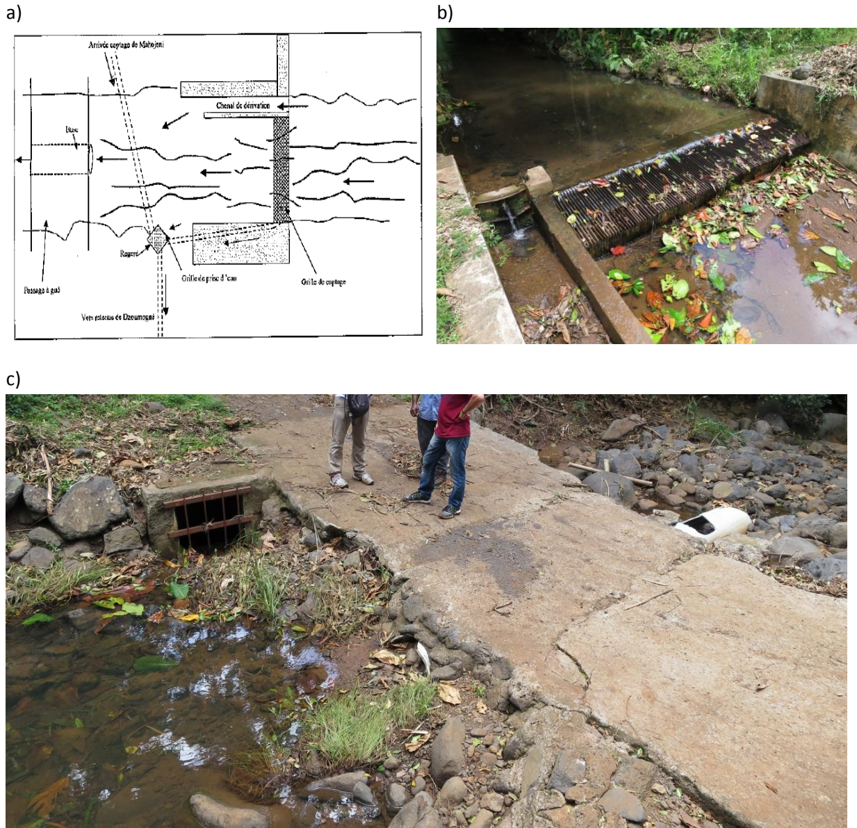
Figure 18. a) Schéma du captage de Mapouéra ; b) Grille de captage ; c) Regard et passage à gué
