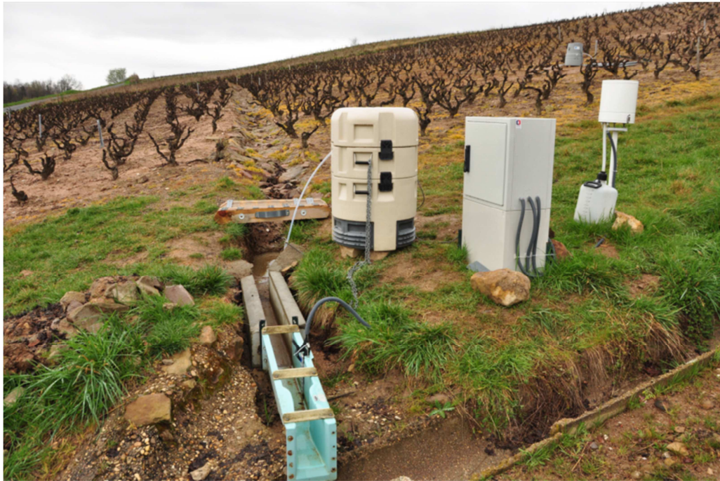
Figure 13. Dispositif de mesure et de collecte du ruissellement (au centre), bloc contenant la centrale d'acquisition des données et pluviomètre (second plan à droite) et aperçu du préleveur affecté à la collecte de l'eau de subsurface (au fond) sur le site de Ruyère.
