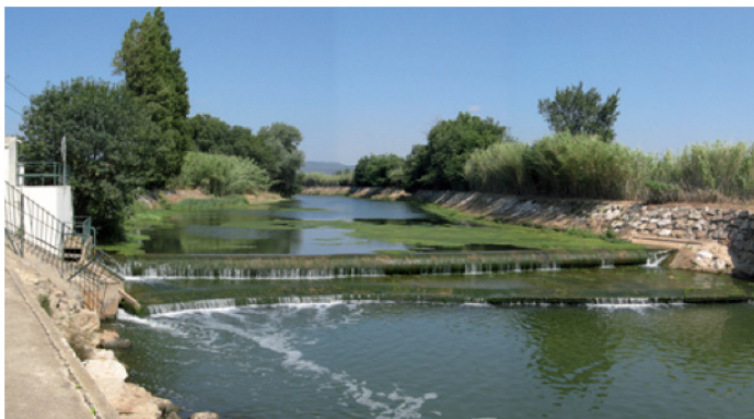
Photo 5. Digue gonflable amovible en période de crues sur le Gapeau. Elle maintient la nappe en charge et empêche la remontée du biseau salé
