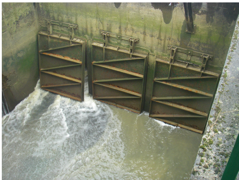
Illustration 7 Portes à flots, obstacle à la circulation des poissons
