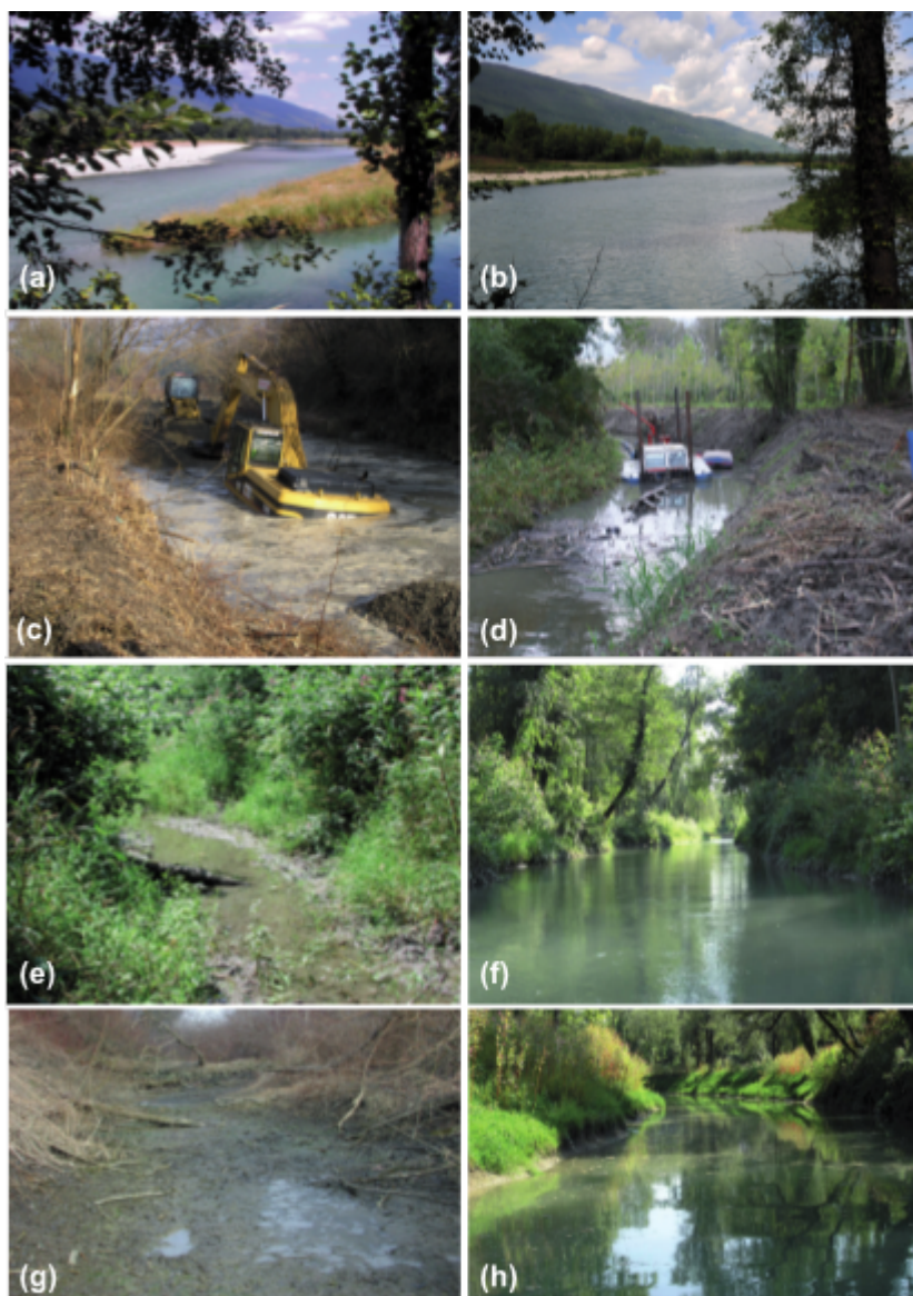
Illustrations – Vieux-Rhône de Chautagne avant (a) et après (b) augmentation du débit réservé ( 20 et 70 \text{ m}^3 \cdot \text{s}^{-1} respectivement); travaux de creusement de la Lône Vachon (c) et dragage dans la Lône Moiroud (d), Lône Mathan (e, f) et Lône des Molottes (g, h) avant (e, g) gauche) et après restauration (f, h).
