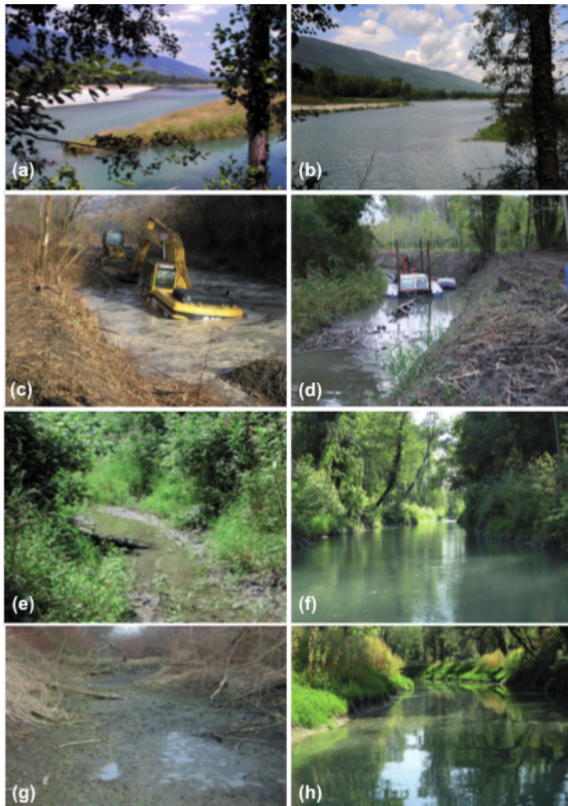
Illustrations – Vieux-Rhône de Chautagne avant (a) et après (b) augmentation du débit réservé (20 et 70 m 3 .s -1 respectivement); travaux de creusement de la Lône Vachon (c) et dragage dans la Lône Moiroud (d), Lône Mathan (e, f) et Lône des Molottes (g, h) avant (e, g) gauche) et après restauration (f, h).
