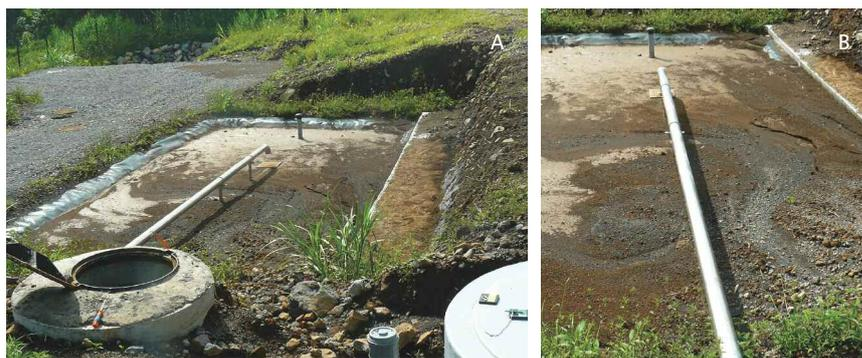
Figure 27. Coulée de boue sur le filtre planté de végétaux (FPV) de Salazie à la Réunion.
