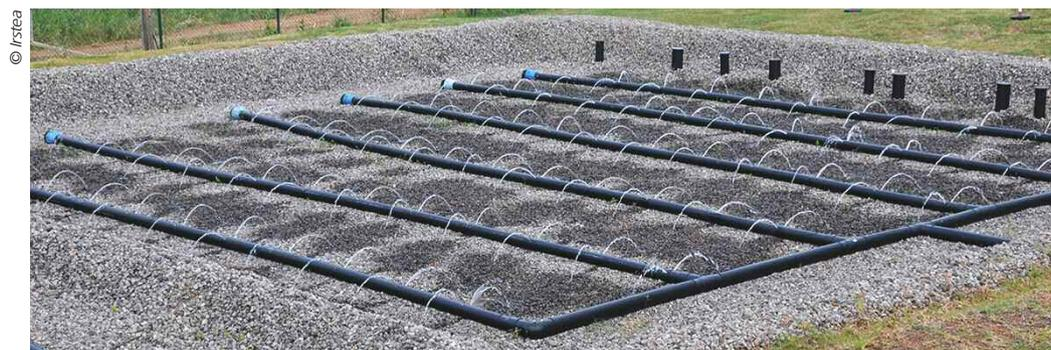
Figure 8. Alimentation sur le 2<sup>e</sup> étage de la station de Mansarde Rancée (Martinique) avant plantation, février 2014.
