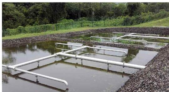
Figure 13. Mise en charge des filtres de la station de Taupinière au cours de la tempête Matthew. Ce sont les filtres de la 2<sup>e</sup> ligne de la station qui ne sont pas encore en service et donc ne sont pas plantés, faute de charge suffisante.
