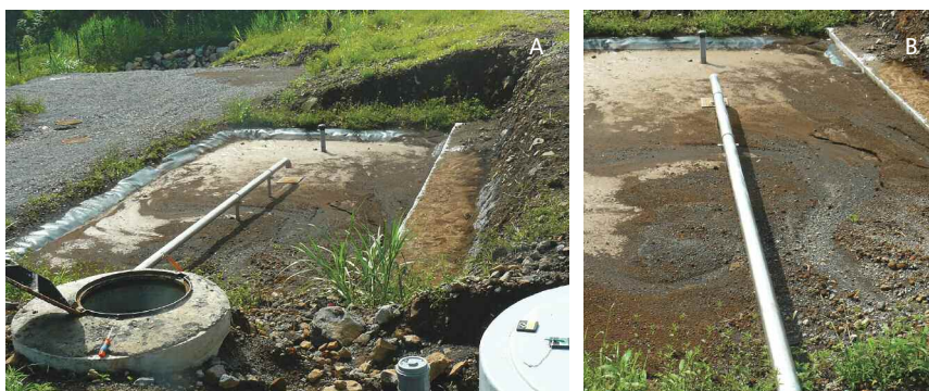
Figure 27. Coulée de boue sur le filtre planté de végétaux (FPV) de Salazie à la Réunion.
