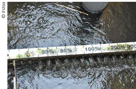
Figure 6. Lame crénelée pour recirculation manuelle.
