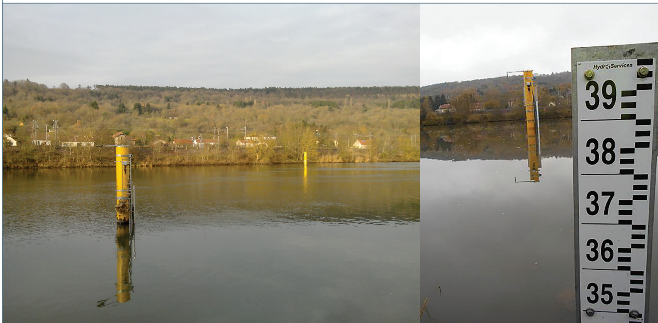
FIGURE 3.5 : STATION HYDROMÉTRIQUE À RELATION VITESSE-DÉBIT ET MESURE PAR ULTRASON ET TEMPS DE TRANSIT, LA MOSELLE À CORNY, 7 762 KM 2 (DREAL GRAND EST, UH MEUSE MOSELLE)
