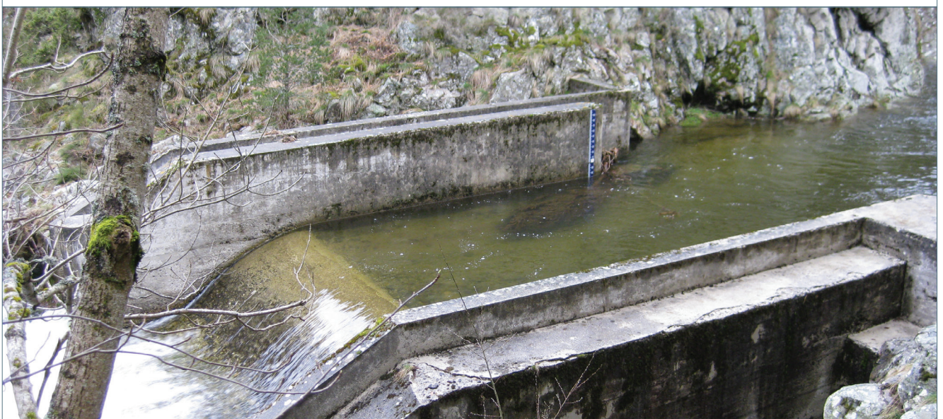
FIGURE 2.3 : SEUIL AVEC PASSE BAS DÉBIT DU GAGE À RANC DE PIOUCHE, AFFLUENT DE LA LOIRE, 18 KM 2 , (EDF-DTG)
