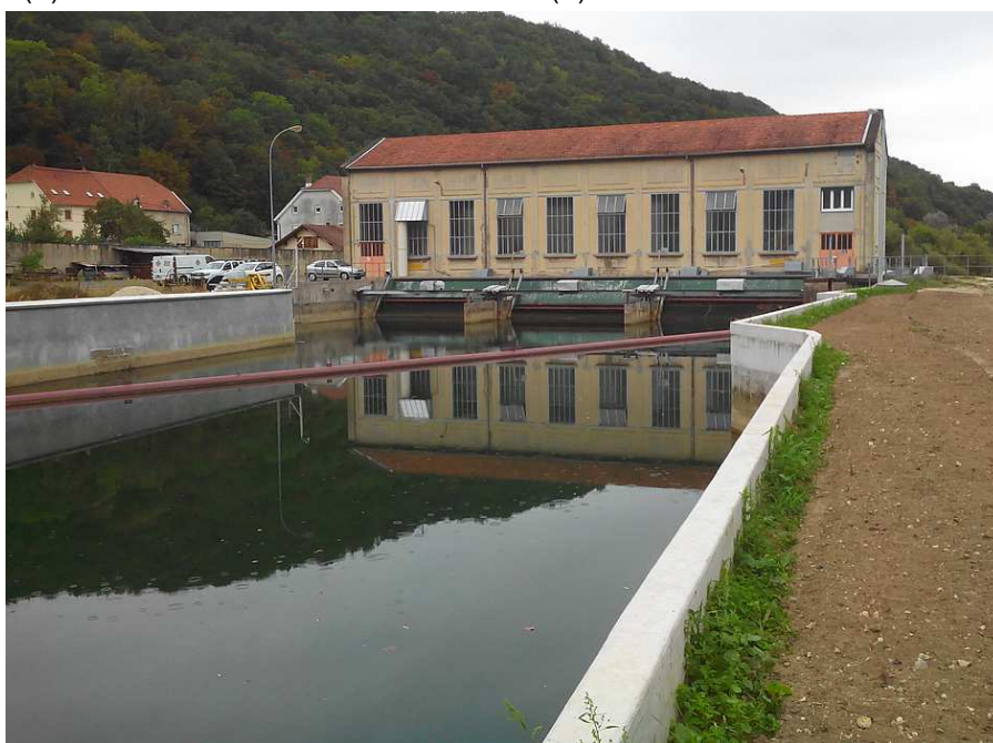
(c) Usine hydroélectrique
