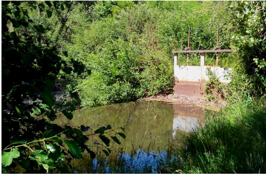
(a) Seuil de dérivation et vannes en entrée du canal d'amenée
