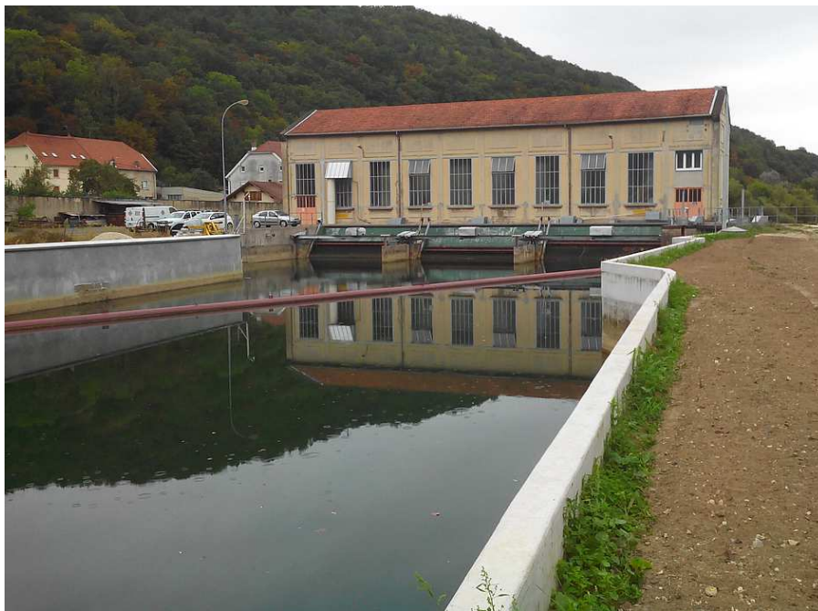
(c) Usine hydroélectrique
