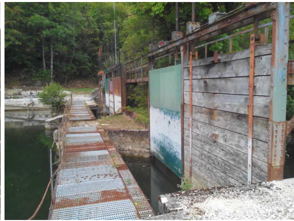
(b) Vannes d'entrée du canal d'amenée
