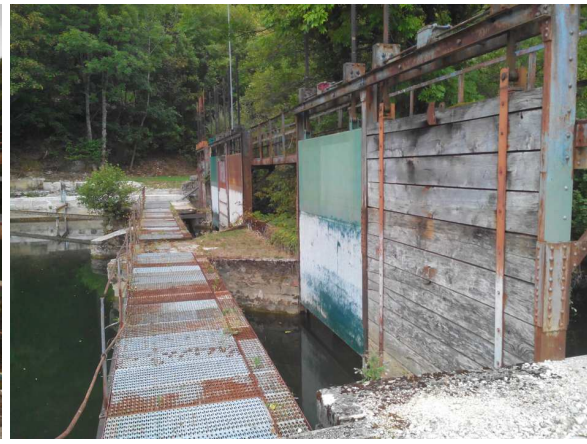
(b) Vannes d'entrée du canal d'amenée
