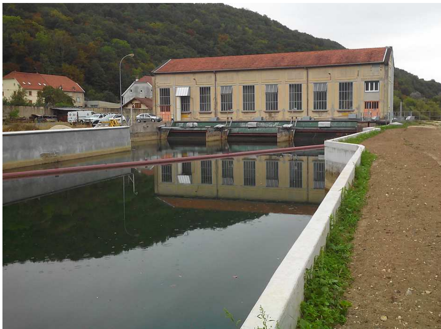
(c) Usine hydroélectrique
