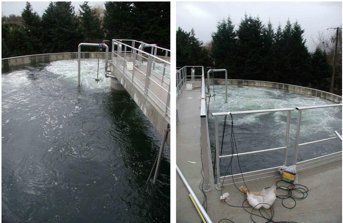
photographie 1 : Champs de bulles durant la mesure de la capacité d'oxygénation en eau claire du dispositif d'aération de la station d'épuration d'Izon (33)
