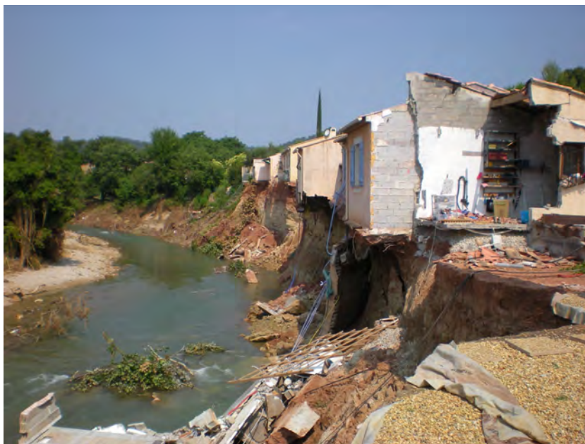
FIGURE C.17 Rangée de maisons à détruire suite aux inondations de la Naturby, à La Motte. Photo : S. Vachald.
