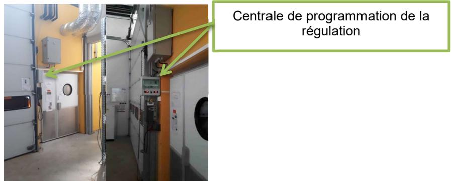
photo 1 : Emplacement de la centrale de programmation de la régulation
