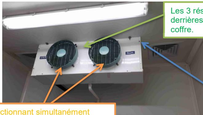
Les 3 résistances électriques sont placées derrière ces deux ventilateurs dans le coffre.
