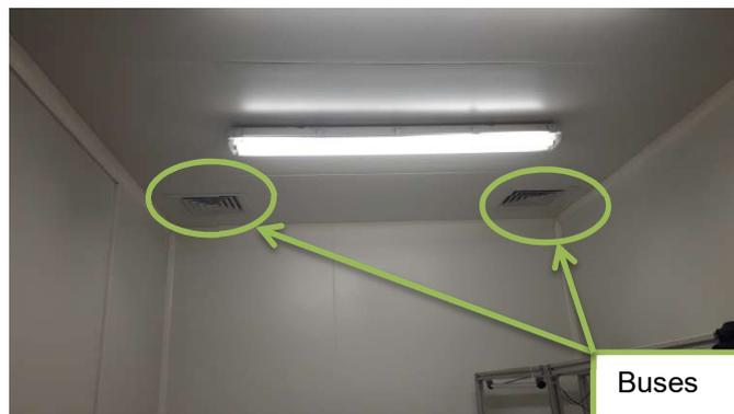
photo 6 : Emplacement des buses d'extraction d'air
