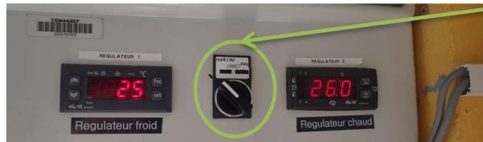
Bouton interrupteur mise en marche et arrêt de la régulation de température
