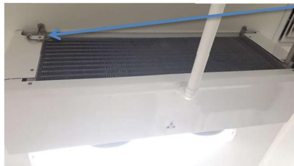
Les sondes de température de la centrale de programmation de régulation sont placées entre le coffre et le mur.
