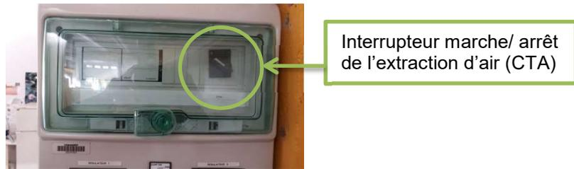
photo 5 : Interrupteur marche/ arrêt de l'extraction d'air (CTA)
