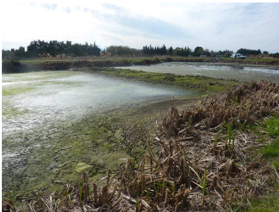
Photo 1 : Bassin B1 lors de sa vidange pour travaux (au premier plan, la zone située proche du bypass dont la vidange est plus simple. Derrière la digue, l'eau est restée bloquée et ne s'est pas infiltrée).
