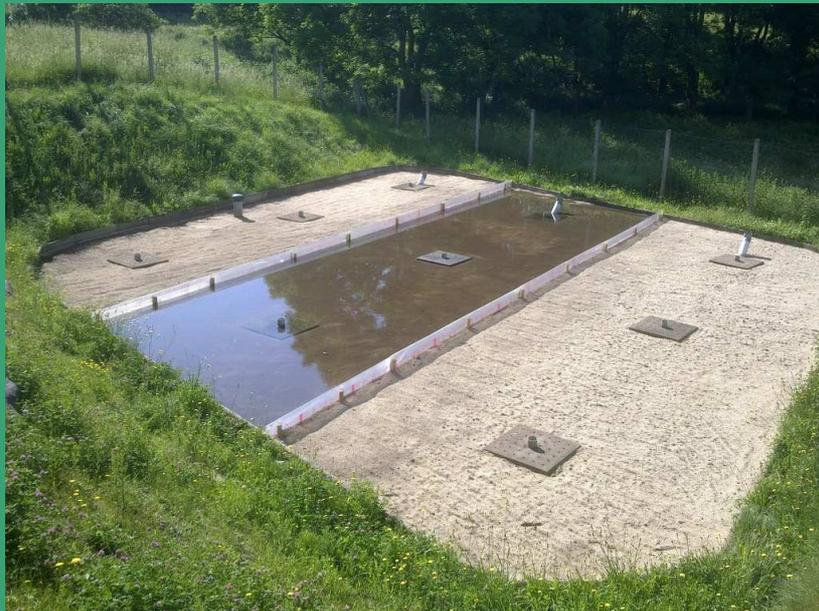
*Bassin d'infiltration-percolation alimenté (section centrale) et scarifié*
