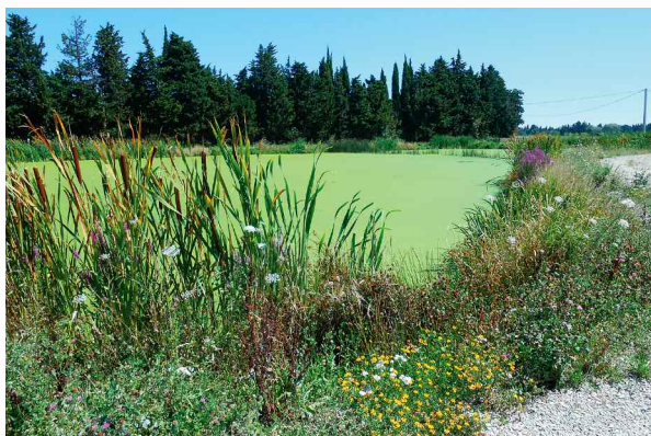
Figure 12. Bassin d'une zone de rejet végétalisée envahi par des lentilles.
