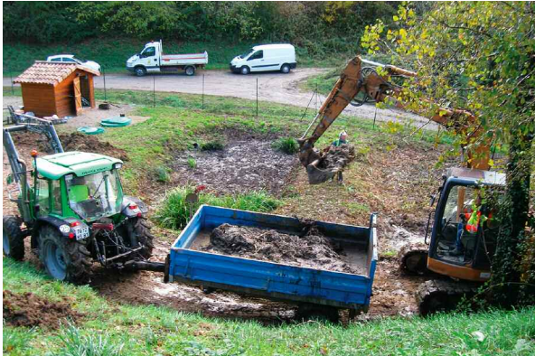
Figure 14. L'envasement des ZRV nécessite un curage.
