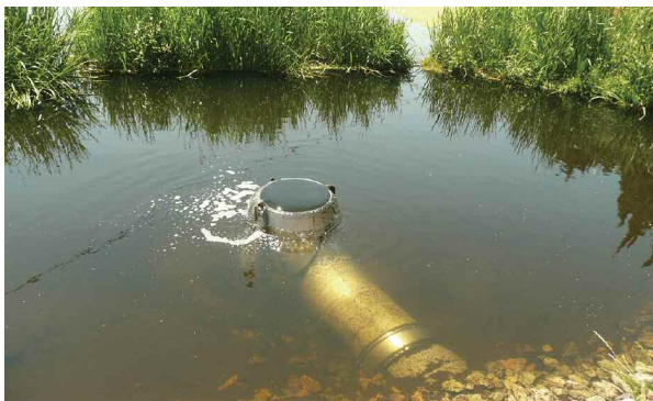
Figure 3. Arrivée de l'eau, issue d'une station d'épuration des eaux usées, dans la zone de rejet végétalisée.
