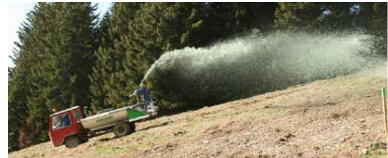
Figure 61 : Ensemencement hydraulique
