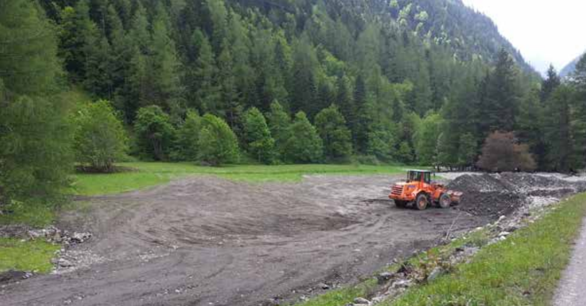
Figure 31 : Travaux du sol réalisés après le passage de la lave torrentielle
