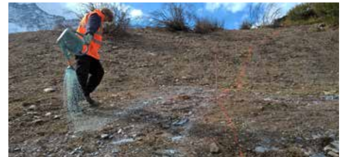
Figure 43 : Adjonction de colle pour fixer les graines dans un environnement très venteux
