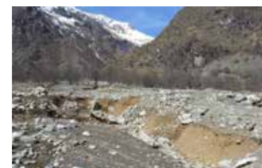
Figure 24 : Dégâts causés par la lave torrentielle dans la prairie de fauche
