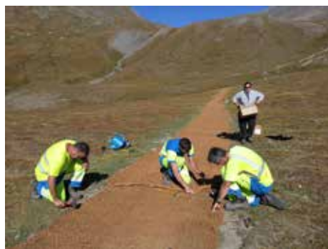
Figure 19 : Pose du géotextile
