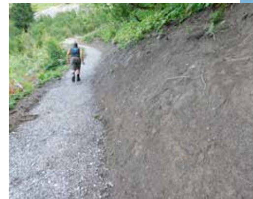
Figure 65 : Zone raide propice à l'érosion.
