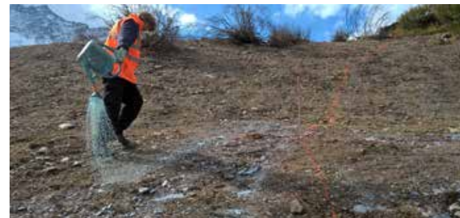
Figure 43 : Adjonction de colle pour fixer les graines dans un environnement très venteux
