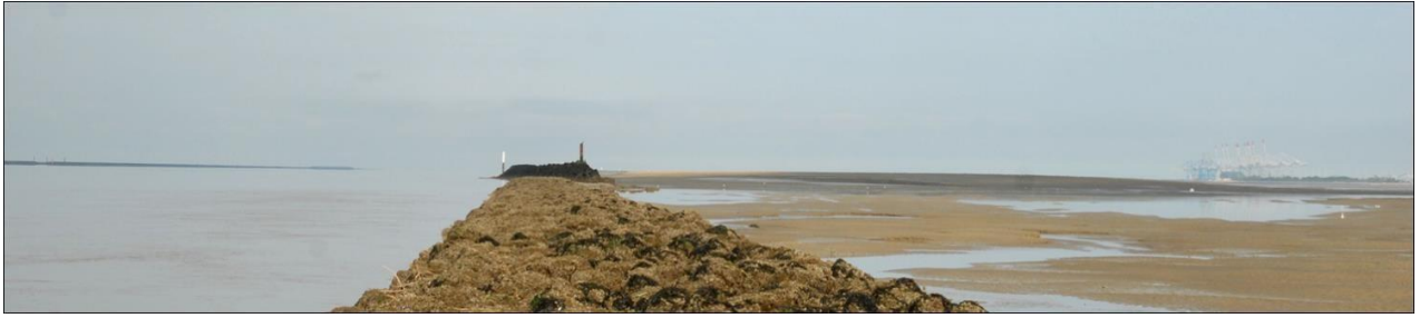
Figure 4. Vue de la digue submersible à marée basse. A gauche, le chenal de navigation. Photo S. Moussard (GIPSA).
