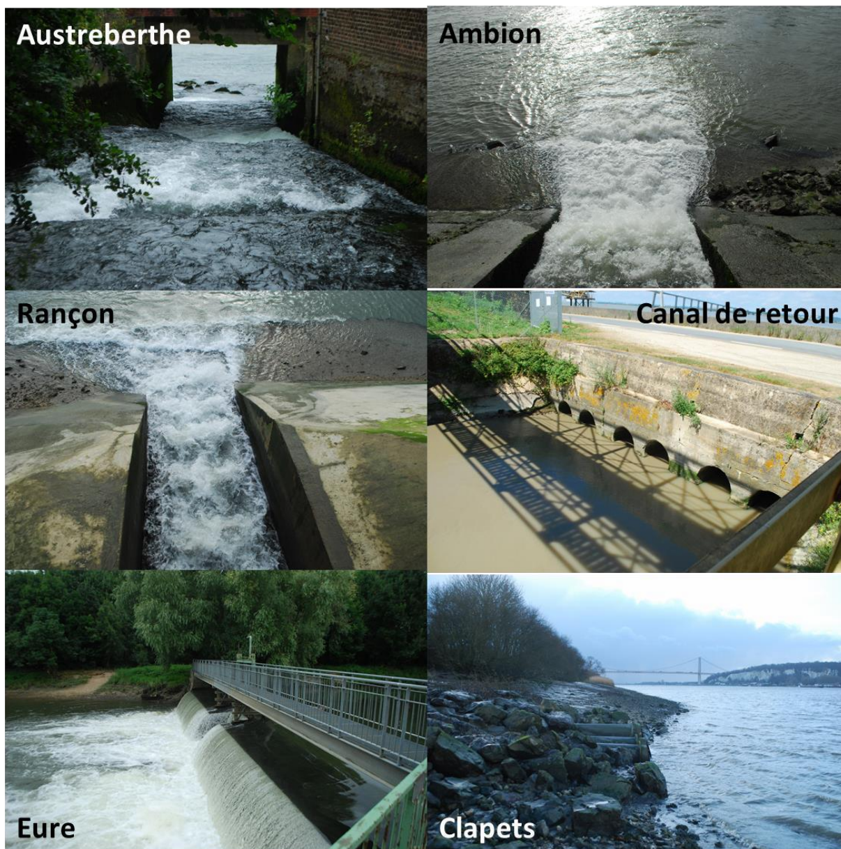
Figure 8. Exemple de confluence entre la Seine et quelques affluents. Le canal de retour « Nord-Sud » porte les eaux du Joble et de la Morelle à la Seine. Les clapets anti-retour équipent les fossés du Marais Vernier.
