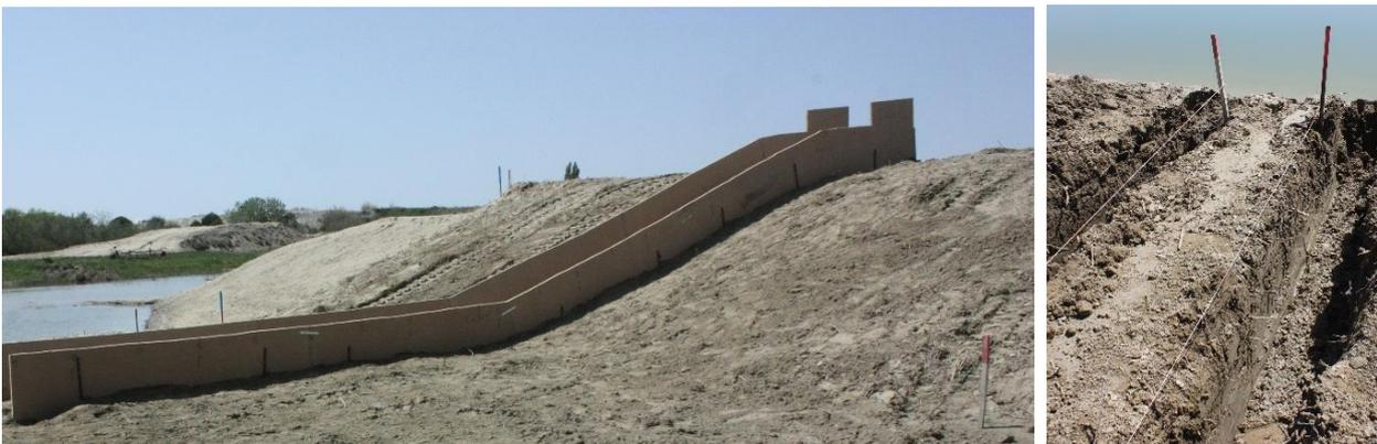
Figure 20 : Construction des canaux d'essais avec fichage des panneaux dans le remblai, source : IRSTEA
