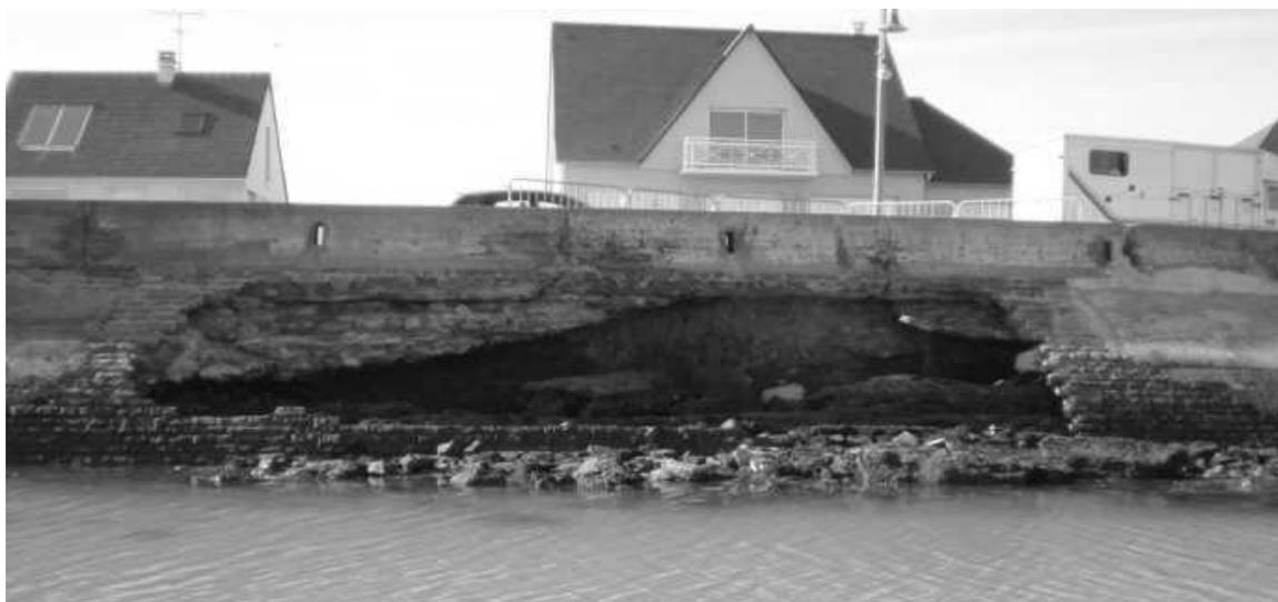
*Figure 16 : Développement excessif d'une cavité dans la digue d'Asnelles, mai 2011, source : DDTM du Calvados*
