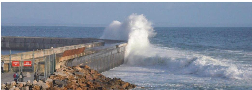
Figure 49 : Exemple d'un « wave return wall », avec un rebord côté mer limitant le franchissement, source : EurOtop 2016
