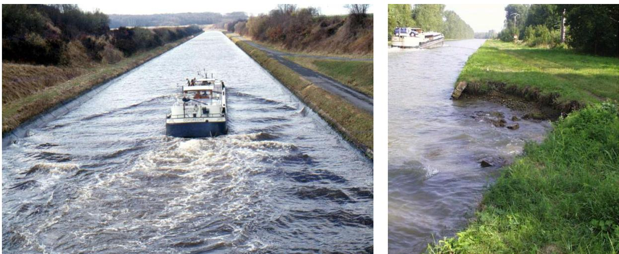
Figure 9 : Ondes générées par le passage d'un bateau et affouillement résultant d'une berge, source : CEREMA
