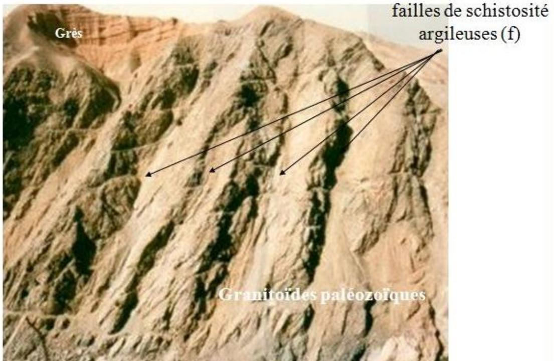
Figure 3 : Appui rive gauche du barrage de Lijaxia en Chine (granite à gros cristaux-schiste-migmatite)
