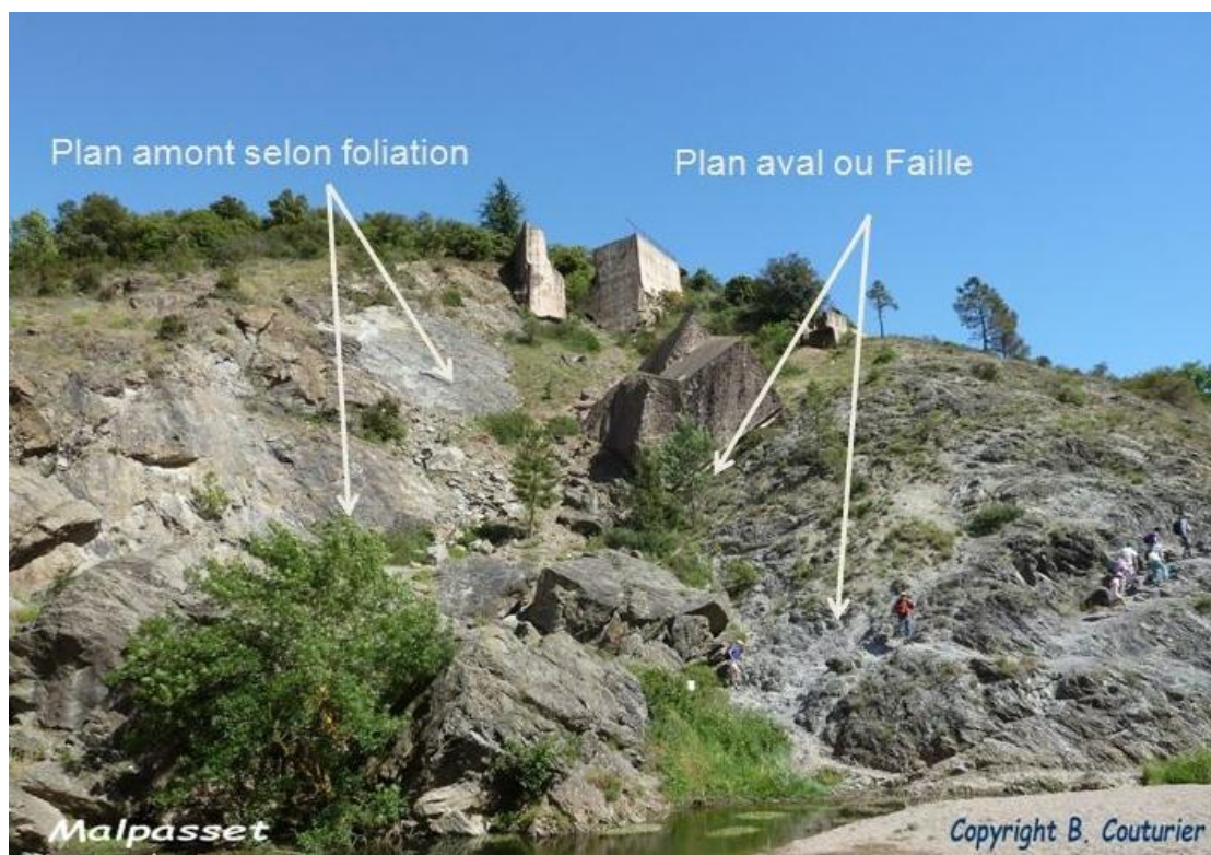
Figure 1 : Dièdre de Malpasset (gneiss- gneiss oeillé massif - micaschistes écrasés),
