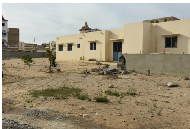
Figure 32 Nouveau poste de santé du quartier Tacco
