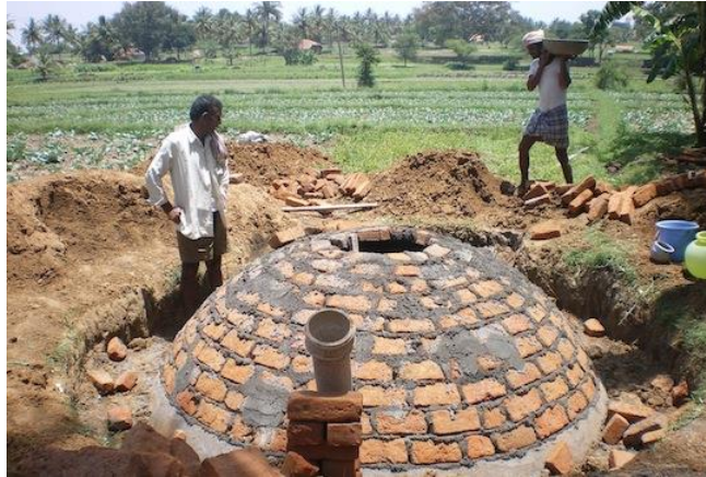
Figure 93 Construction d'un réacteur à Biogaz en Inde
