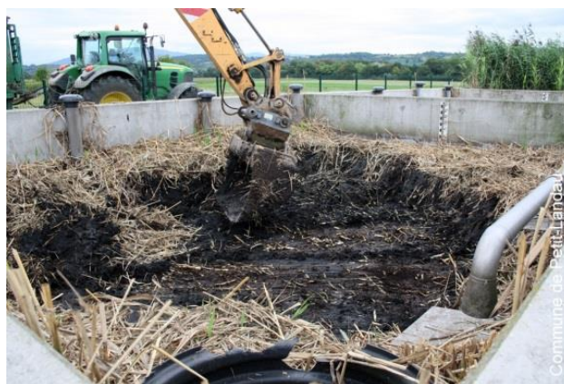
Figure 95 Extraction de l'humus du lit de séchage planté après plusieurs années de fonctionnement
