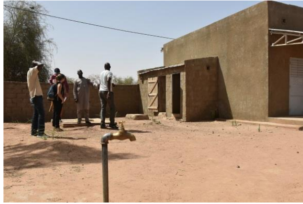
Figure 52 Robinet d'eau courante du Lycée de Ranérou
