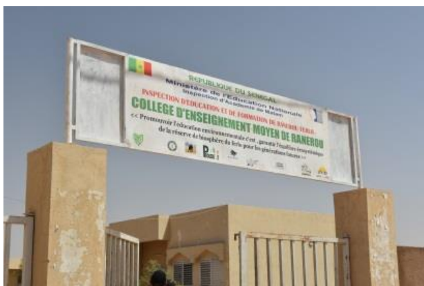
Figure 55 Entrée du collège de Ranérou
