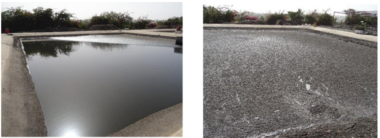
Figure 15 Bassin d'épaississement des boues de vidange de la station de Pikine
