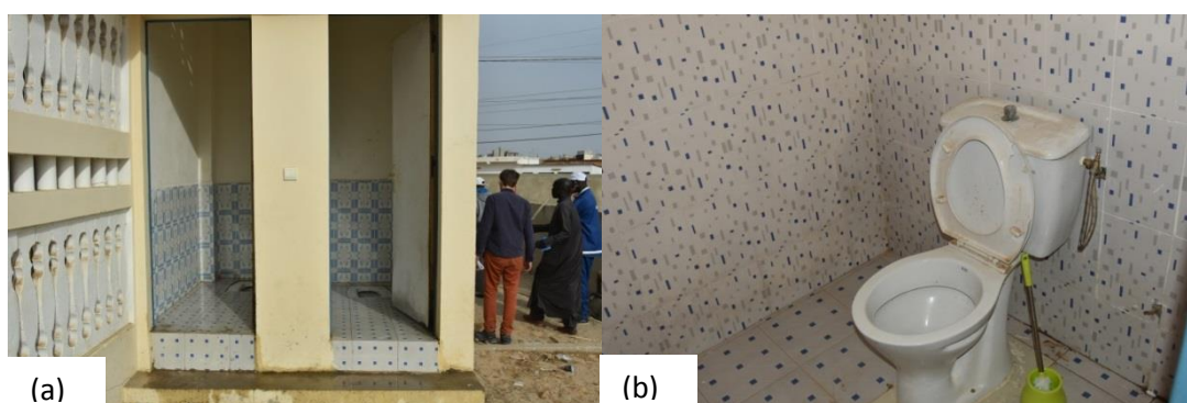
Figure 33 (a) toilettes visiteurs, sans assise, (b) toilette d'une chambre du poste de santé
