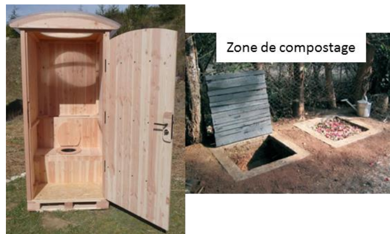
Figure 73 Schéma d'une toilette Ecosan (ou Toilette à litière) et sa zone de compostage (Morgan, 2007)
