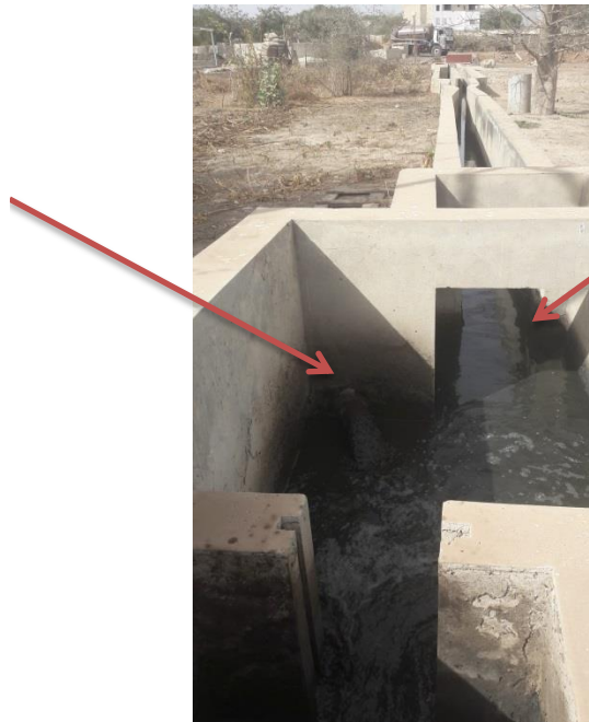
Figure 9 Entrée de la lagune de la station de Rufisque-Nord
