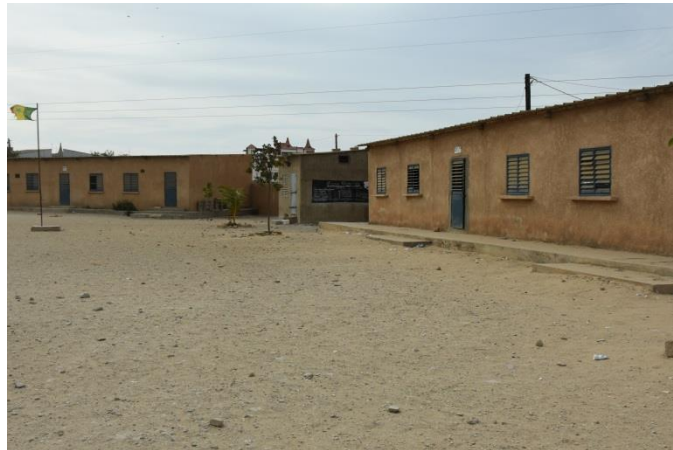
Figure 28 Cours de l'école primaire Shérif 3, Tacco
