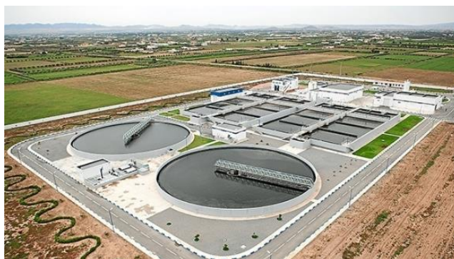
Figure 88 Photo aérienne d'une boue activée
