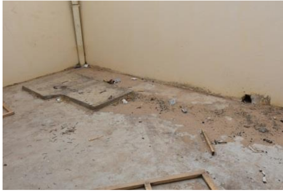
Figure 34 Emplacement de la fosse "septique" enterré du poste de santé
