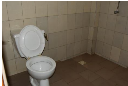
Figure 42 Toilette à chasse d'eau avec assise et douche d'un foyer de classe aisée du quartier SUDES
