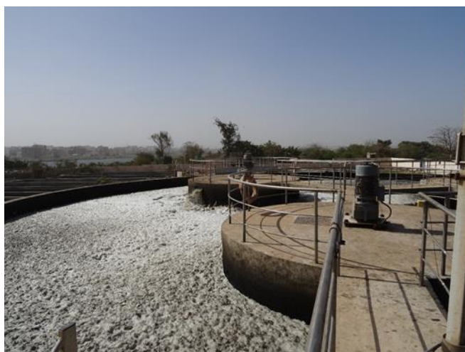
Figure 22 Bassin boue active aéré pour le traitement des eaux usées de Pikine
