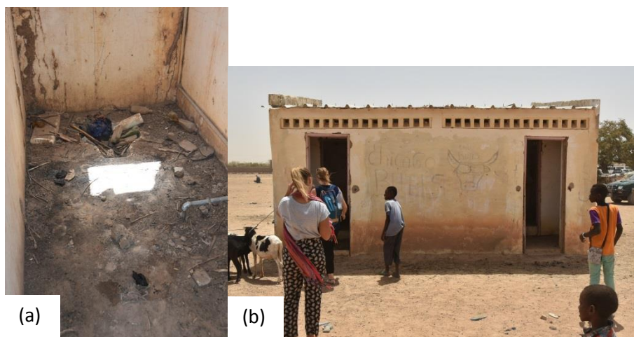
Figure 61 Toilettes du marché de Ranérou (a) toilette à l'abandon, (b) bâtiment
