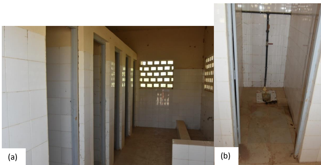
Figure 58 Toilette du collège de Ranérou (a) bâtiments, (b) toilette d'élève
