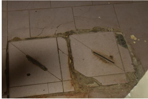
Figure 40 Regard de la fosse « septique » à l'entrée du foyer de classe moyenne, Santa Yalla
