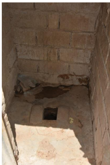
Figure 63 Latrine d'un foyer modeste de Ranérou
