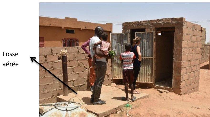
Figure 67 Fosse connectée à la douche et à la toilette du foyer de classe moyenne de Ranérou
