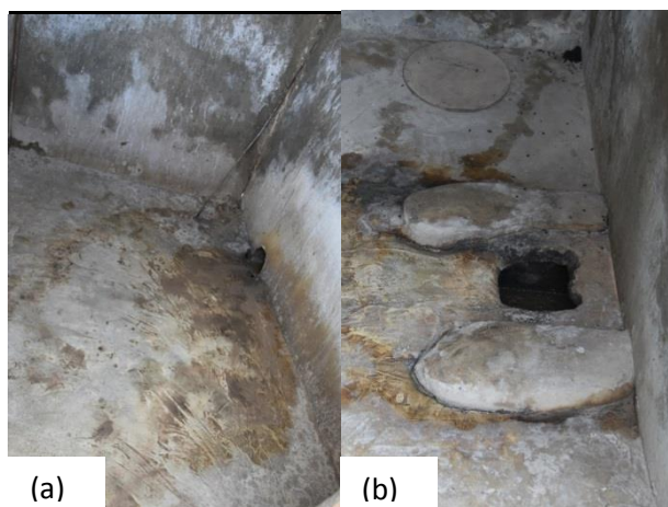
Figure 37 (a) Latrine consolidée, non ventilée et (b) cabine de douche d'un foyer très modeste, Santa Yalla
