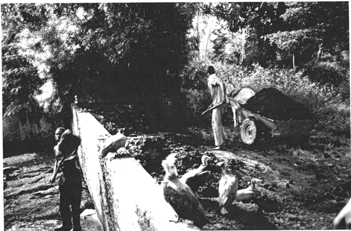
Photo N° 5 : Evacuation des boues.
