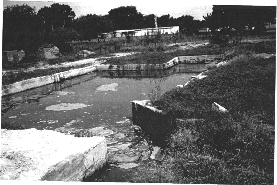
Photo N° 7 : Bassin de stockage de la tannerie.
