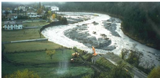
FIGURE 3 : LARGE BRECHE DUE A UNE EROSION EXTERNE SANS DEBORDEMENT - VAR - GUILLAUMES (06) - 1994 (ONF)
