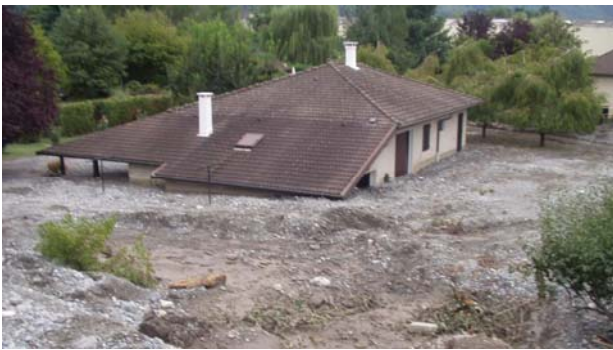
FIGURE 8 : MAISON ENGRAVEE SUITE A UNE BRECHE DANS LA DIGUE - DOMENON - DOMENE (38) - 2005 (ONF-RTM)
