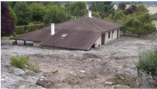
FIGURE 8 : MAISON ENGRAVÉE SUITE À UNE BRÈCHE DANS LA DIGUE - DOMENON - DOMENE (38) - 2005 (ONF-RTM)
