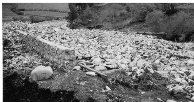
FIGURE 5 : SURVERSE SANS RUPTURE SUITE A L'ENGRAVEMENT DU LIT - CHAGNON - VARS (05) - 1957
