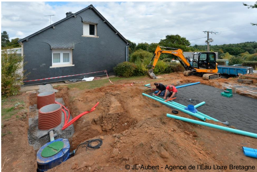
© JL Aubert - Agence de l'Eau Loire Bretagne Figure 9 : Mise en œuvre d'un filtre à sable chez un particulier
