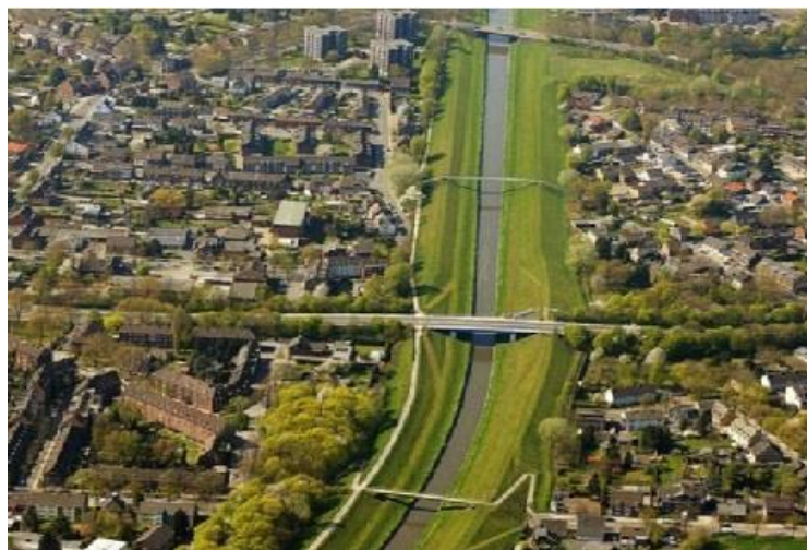
Figure D-7 Levees at the Emscher river in Oberhausen (Photograph: Emschergenossenschaft-Lippeverband in GRÜN, JOHANN, PFISTER 2014)
