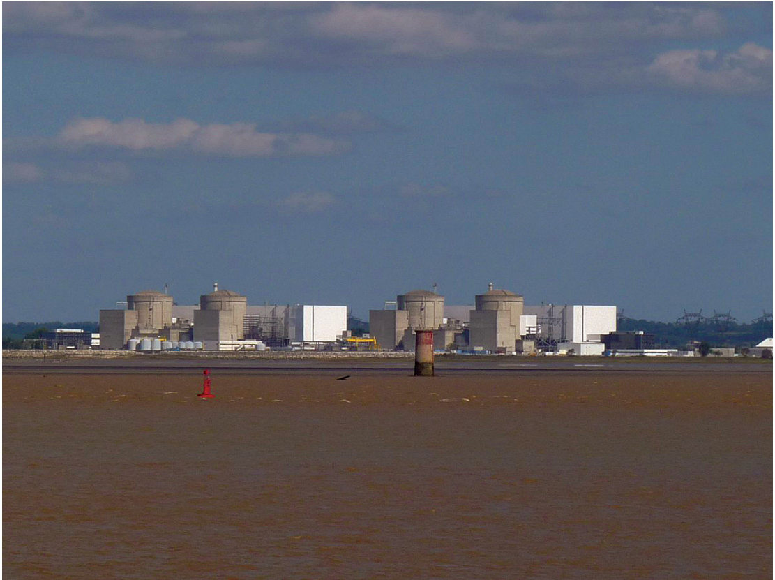
Figure 15 : Centrale nucléaire du Blayais (Wikimedia commons).
