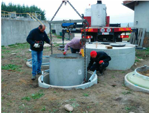
Photo 2. Installation d'un lysimètre dans son alvéole sur la plateforme de Mionnay
