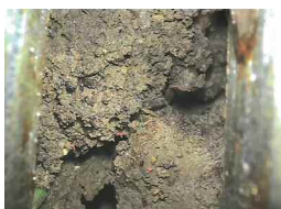
Photographie réalisée à l'aide d'un géoendoscope dans un forage de pénétromètre.
