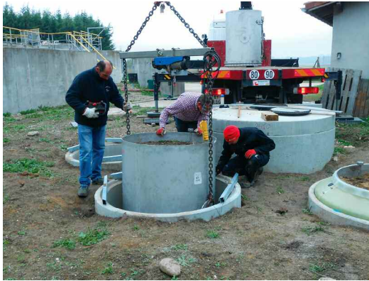
Photo 2. Installation d'un lysimètre dans son alvéole sur la plateforme de Mionnay
