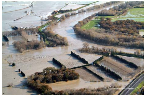
PHOTO 1 : EXEMPLE DE BRECHE (© PHOTO-AERIENNE-FRANCE.FR)
