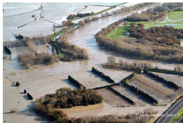
PHOTO 1 : EXEMPLE DE BRECHE (© PHOTO-AERIENNE-FRANCE.FR)
