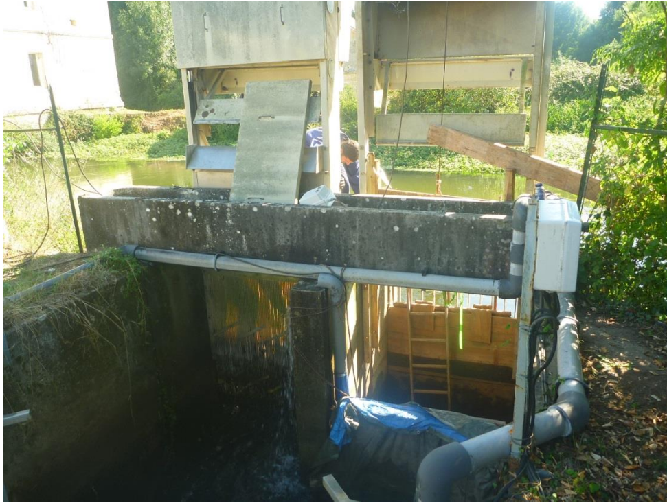
Figure 3 : Début des travaux – mise en place des batardeaux (© P Chèvre, Irstea)
