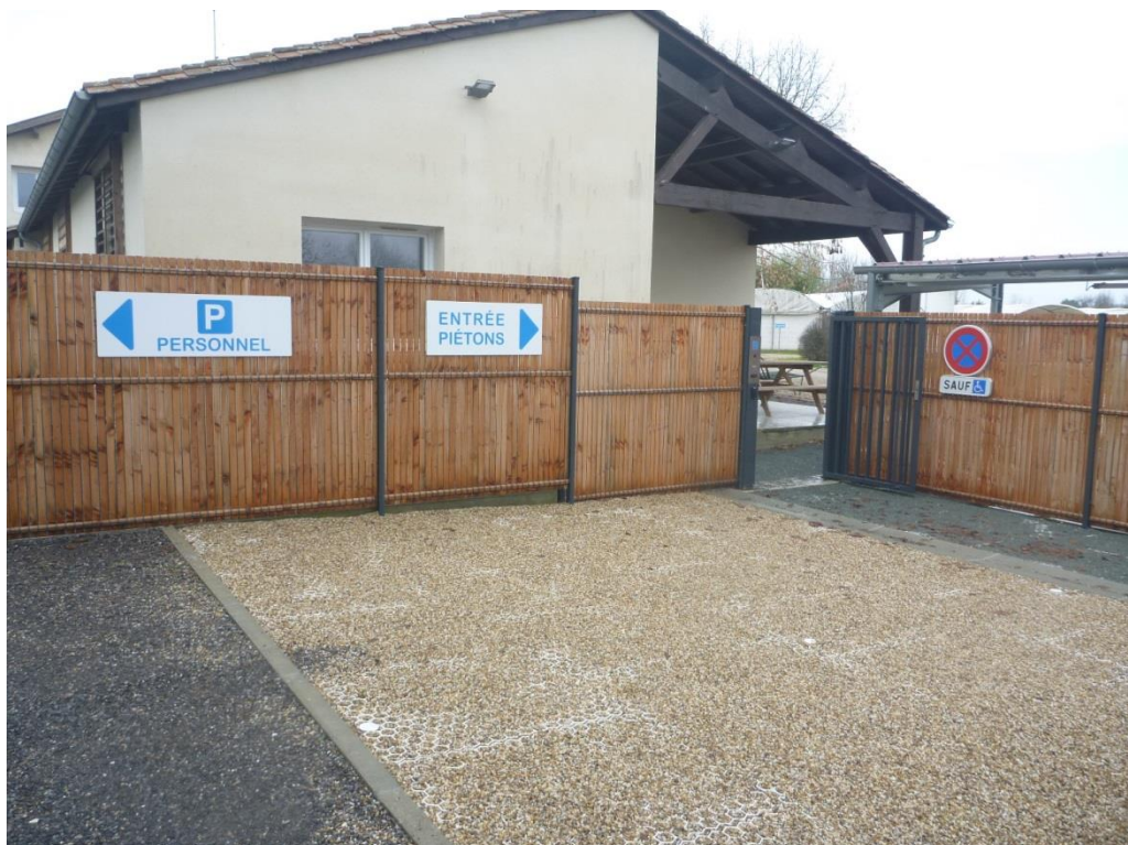
Figure 8 : Entrée piétonne (© P Chèvre, Irstea)
