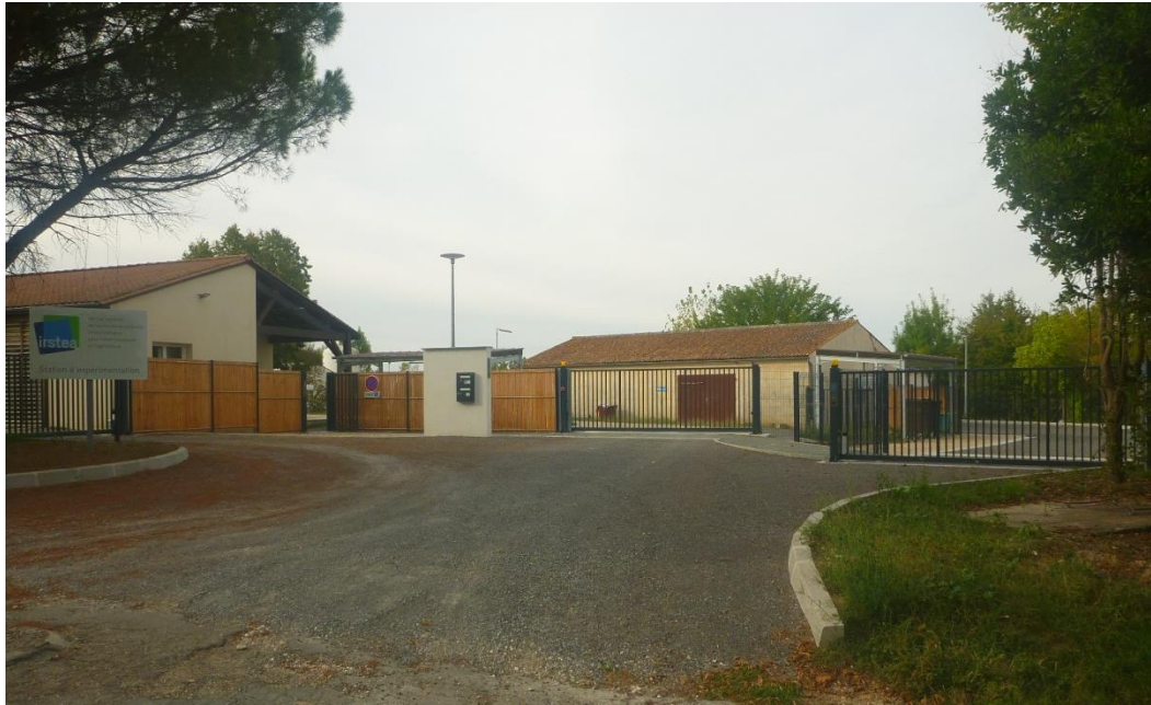
Figure 7 : Entrée principale du site après les travaux (© P Chèvre, Irstea)
