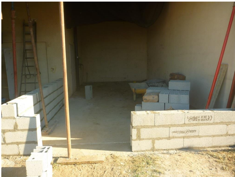
Figure 10 : Début des travaux de l'espace cryoconservation
