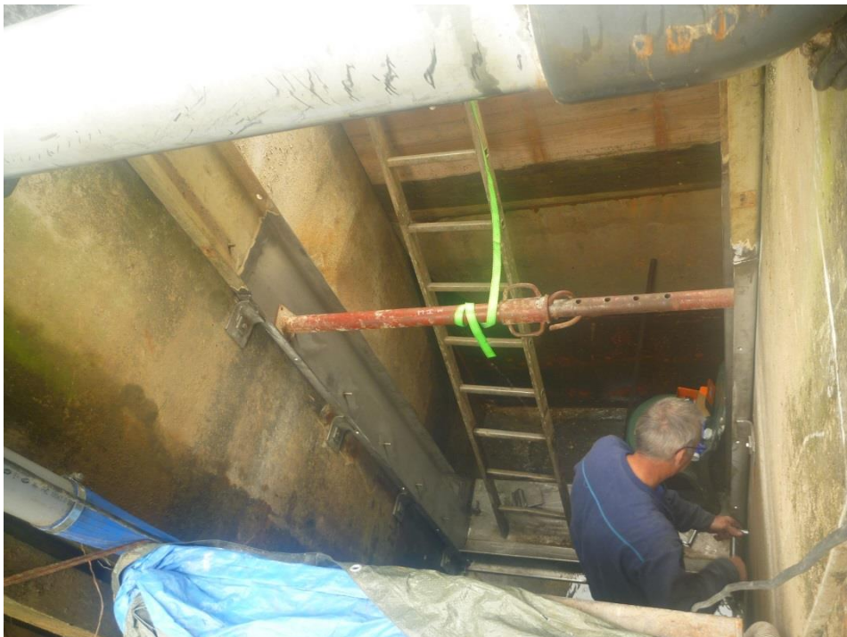
Figure 4 : Mise en place du nouveau dégrilleur (© P Chèvre, Irstea)
