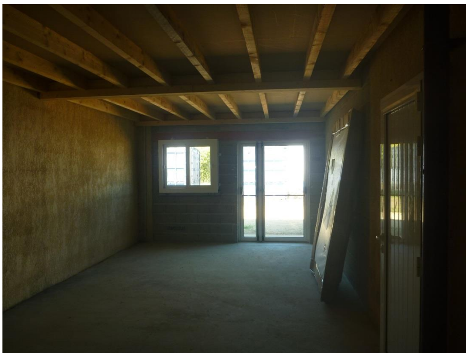
Figure 11 : La partie analyse de l'espace cryoconservation en cours de travaux
